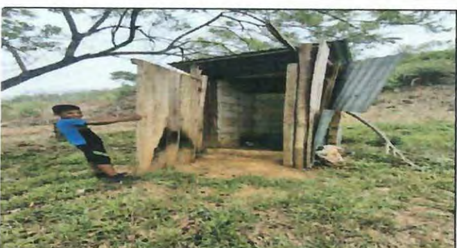
Foto 4: CAMBIO DE PARED Y ENTECHADO DEL BANO
