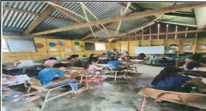
Foto1: CAMBIO DE ENTECHADO DE LA ESCUELA LAMINAS NORMALES POR TROQUELADAS, REPARACIÓN DEL PISO RÚSTICO
