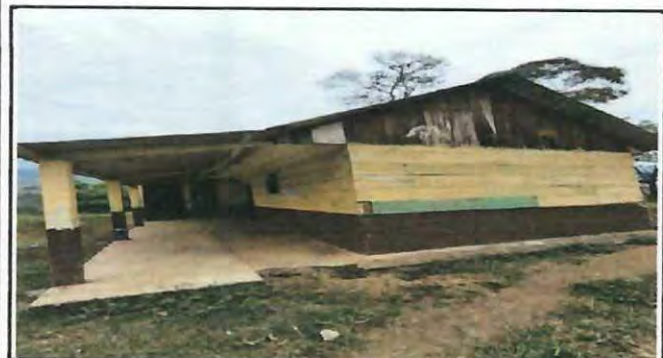
Foto 3: REPARACIÓN DE PAREDES, PARTES DE MADERA POR BLOCK
