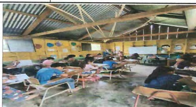
Foto 2: CAMBIO DE VIGAS Y COSTANERAS DE MADERA POR COSTANERAS METALICAS
